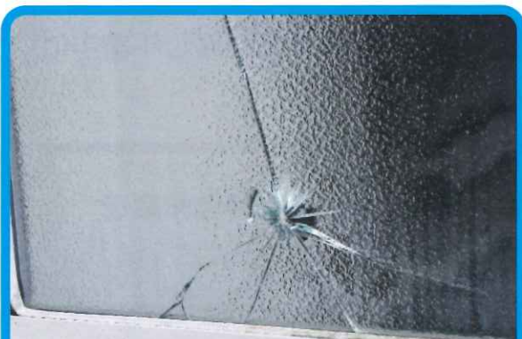
学校の窓ガラス 草刈中の飛び石(ガラス破損)
