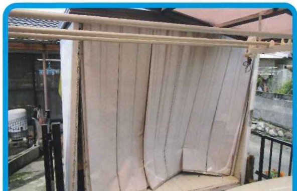
民家の倉庫 車移動中に接触(引き戸破損)
